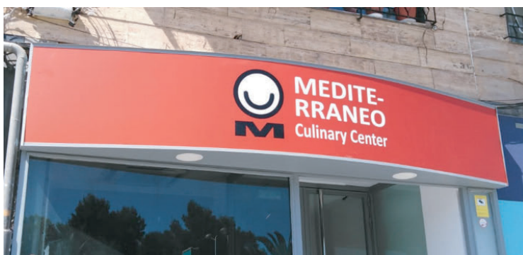
Plafón de metacrilato curvo rotulado con vinilo con iluminación interior y elementos de iluminación hacia fuera.
