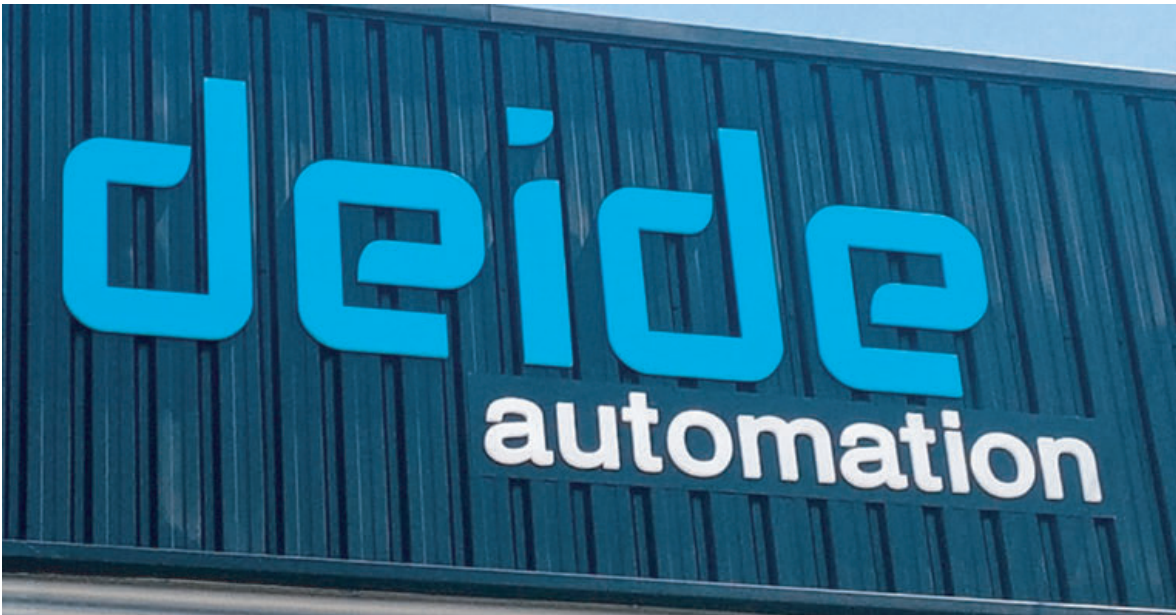
Cartel grande: letras corpóreas de metacrilato azul macizo fresadas y adheridas a la fachada de manera directa
