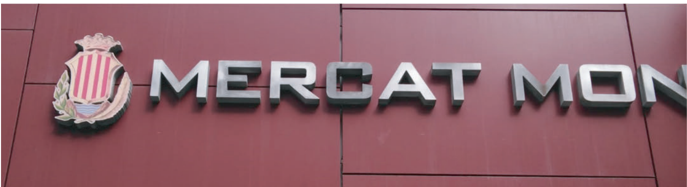
Cartel inferior: letras corpóreas de acero inoxidable, sin iluminación interior, adheridas a la fachada de manera directa
